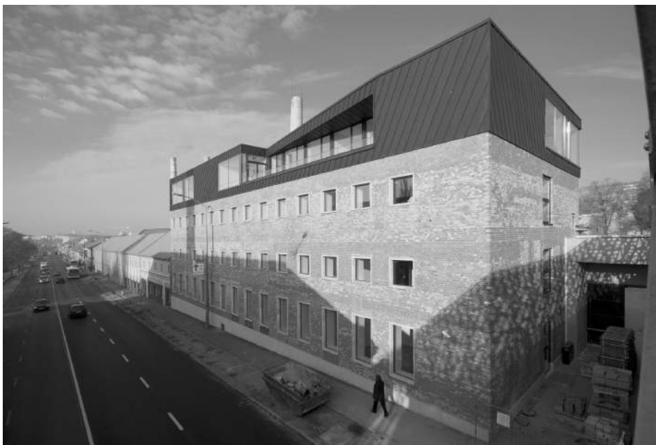
Pillantás a hídról: a Kommunikáció- és Médiatudományi Tanszék épületének Zsolnay úti homlokzata.
