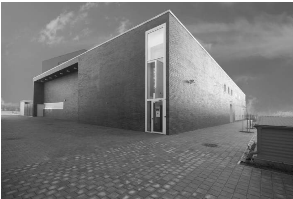
A Szobrász Tanszék és a Janus Egyetemi Színház minimalista tömbje a téglalburkolat révén kapcsolódik a műemlék épületekhez.
